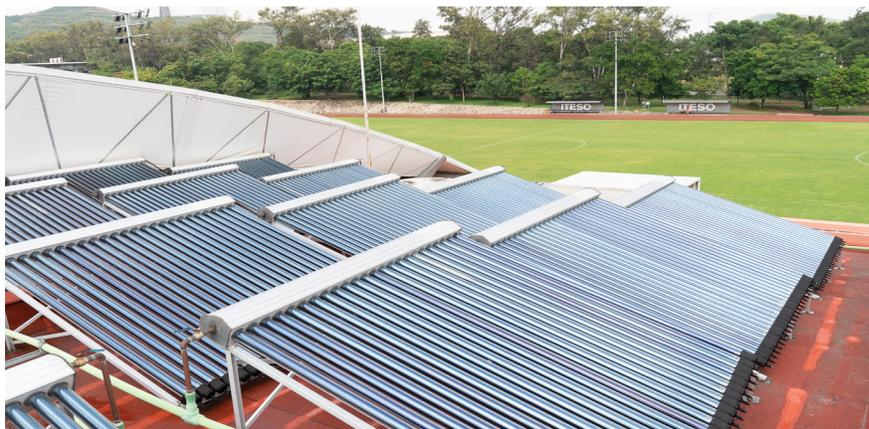
**Imagen 14.** Colectores solares de baja temperatura instalados en el área deportiva del ITESO.
